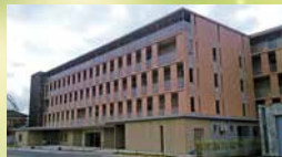
鶴岡市立荘内病院医師公舎
